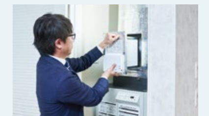
新・UVクリーンユニットはダクトから取り外し可能
